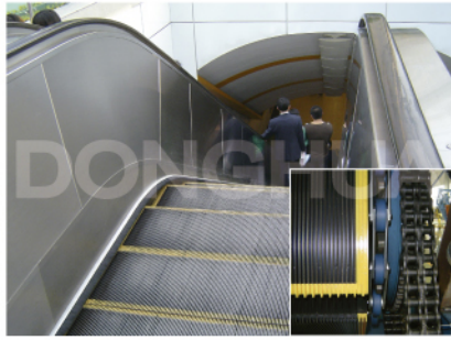
2. Drive chain for escalator Antriebsketten für Fahrtreppen
