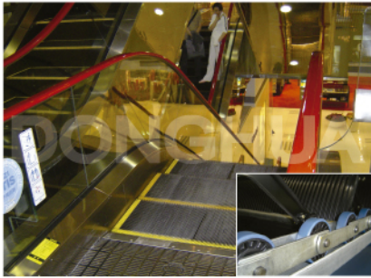
13. Step-chain for escalator Fahrtreppenketten
